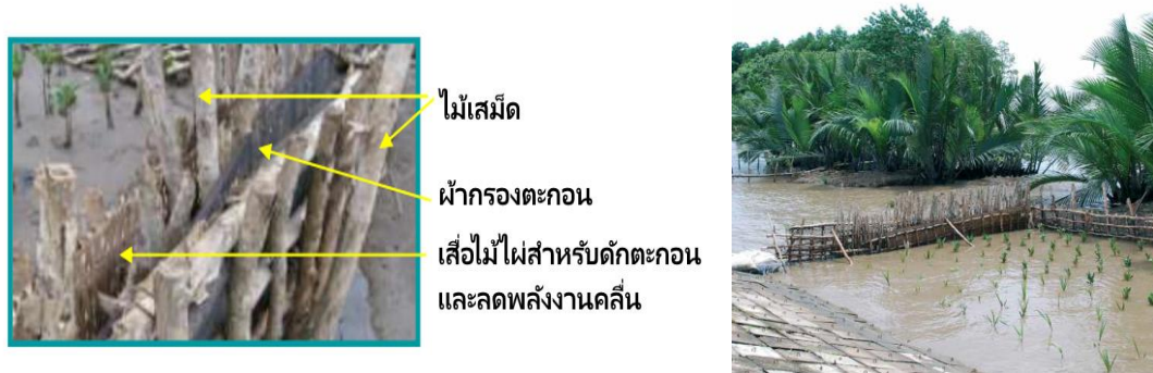
แผนภาพที่ ๒ - ๒๒ รั้วดักตะกอน
