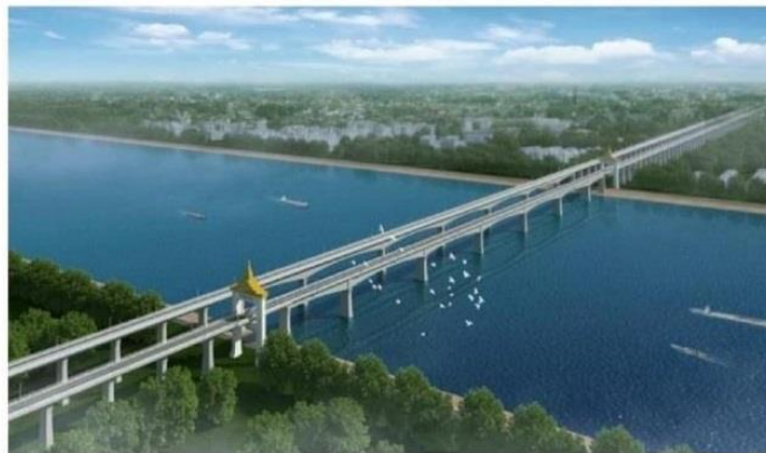
เชื่อมต่อบนสะพานแห่งใหม่ ถัดจากสะพานเดิม 30 เมตร มีทั้งทางรถไฟขนาด 1 เมตร และ 1.435 เมตร
