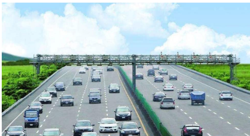
แผนภาพที่ 4-23 ตัวอย่างลักษณะกายภาพระบบ M-Flow
