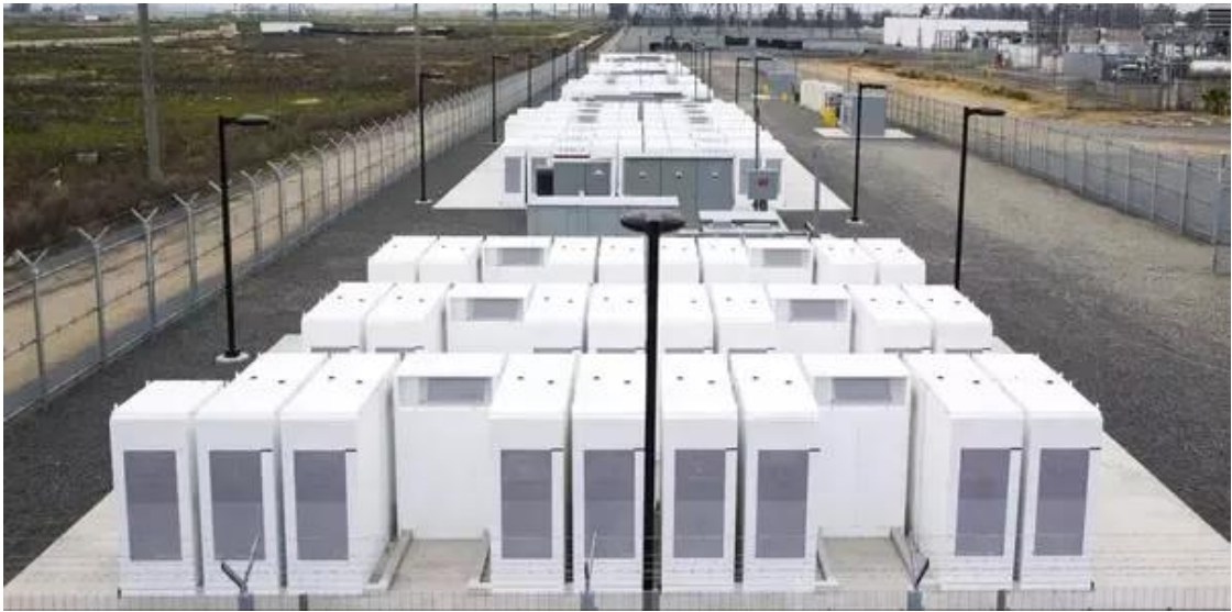
แผนภาพที่ 3-18 รูปแบบหน่วยกักเก็บพลังงานขนาดใหญ่โดยใช้แบตเตอรี่
