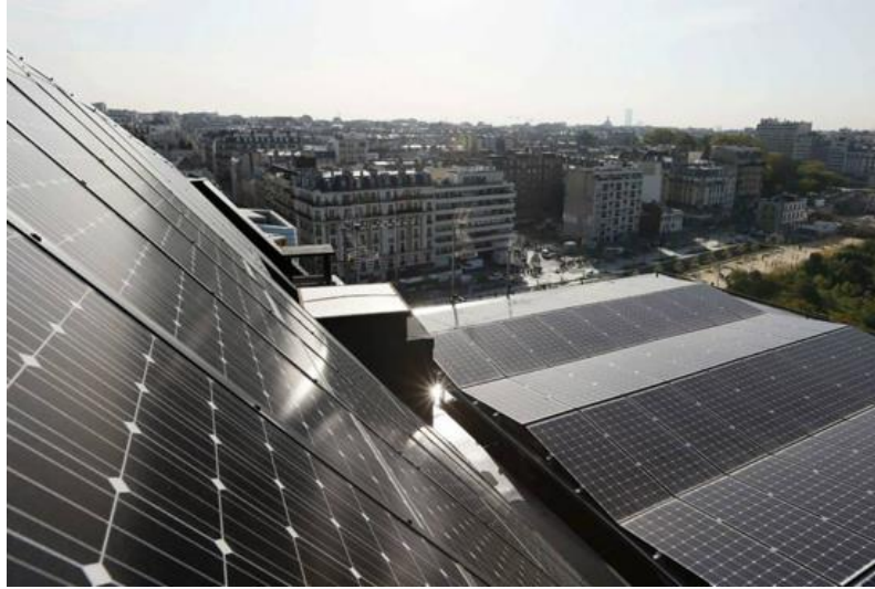
แผนภาพที่ ๒ - ๓๑ การใช้พลังงานแสงอาทิตย์ด้วยแผง Solar cell
