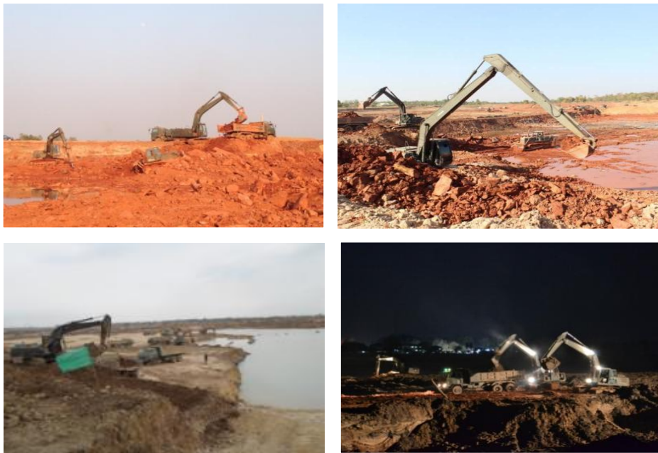
แผนภาพที่ ๔-๑ ภาพการขุดลอกแก้มลิงหนองเลิงเปือย
