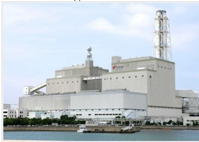
แผนภาพที่ ๔-๒ โรงไฟฟ้ามัตซุอูระ (Matsura Power Plant) ประเทศญี่ปุ่น
