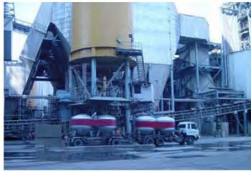
การจ่ายเถ้าลอยจากไซโลลงรถบรรทุก
