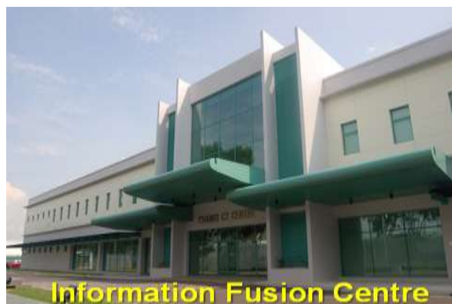
แผนภาพที่ ๓ - ๒๐ อาคาร Changi C2 Centre ฐานทัพเรือชางฮี
