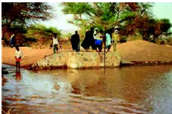
แผนภาพที่ ๓ - ๑๔ การผันน้ำเข้าสู่สระเติมน้ำในช่วงฤดูน้ำหลาก
