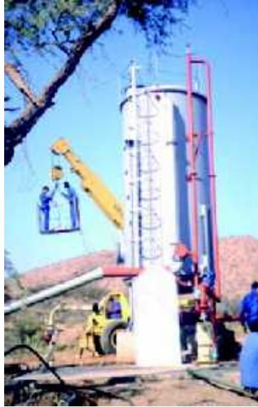
แผนภาพที่ ๓ – ๖ การสร้างระบบกรองน้ำดิบใกล้บ่อเติมน้ำใน Windhoek (Gale, ๒๐๐๕)
