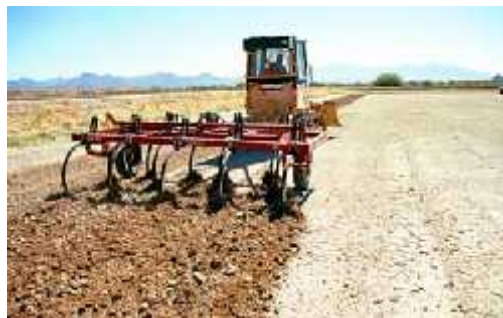
(ง) การพรวนดินสระเติมน้ำโดยใช้รถไถติดคราด
