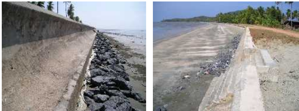
แผนภาพที่ ๓-๕ กำแพงป้องกันการกัดเซาะชายฝั่งทะเลที่บริเวณถนนเลียบฝั่งอ่าวทุ่งวิมาน อำเภอนายายอาม จังหวัดจันทบุรี ปี ๒๕๕๐ - ๒๕๕๑
