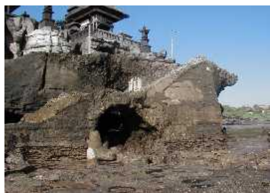
แผนภาพที่ ๓-๑๒ สภาพความชำรุดเสียหายของ วัด Tanah Lot จากผลกระทบการกัดเซาะ
