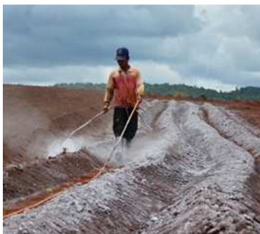
แบบคนเดินฉีดพ่นด้วยเครื่องฉีดพ่น
