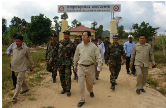
ภาพที่ 3-25 นายเจีย โชะพารา รัฐมนตรีว่าการกระทรวงพัฒนาชนบท ตรวจการก่อสร้างศูนย์สุขภาพเดโชมรกต อำเภोजอมกระสาน จังหวัดพระวิหาร และโรงเรียนประถมศึกษาทมอโตน จังหวัดอุตรดิตถ์ (เมื่อวันที่ 23 มกราคม พ.ศ.2555)
