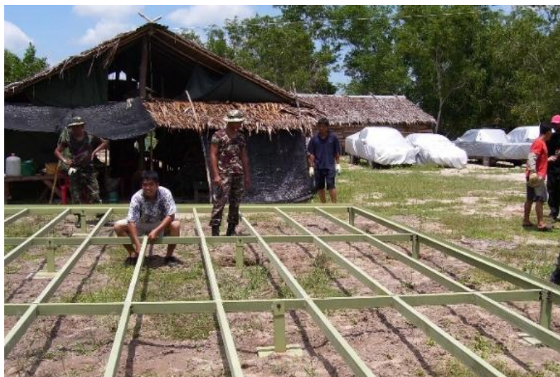
แผนภาพที่ 3-7 การประกอบติดตั้งชิ้นส่วน โครงสร้างเสาคานเหล็ก
