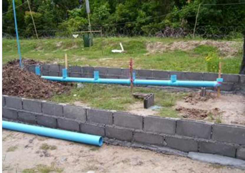
แผนภาพที่ 3-10 การก่อสร้างเมนดับล็อกโดยรอบและวางท่อ พี.วี.ซี.
