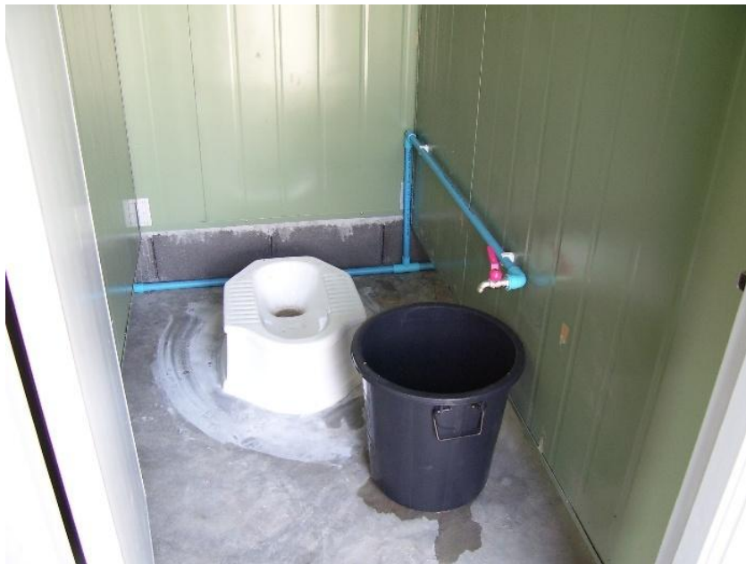
แผนภาพที่ 3-14 ลักษณะภายในของห้องน้ำเมื่อประกอบติดตั้งแล้วเสร็จ
