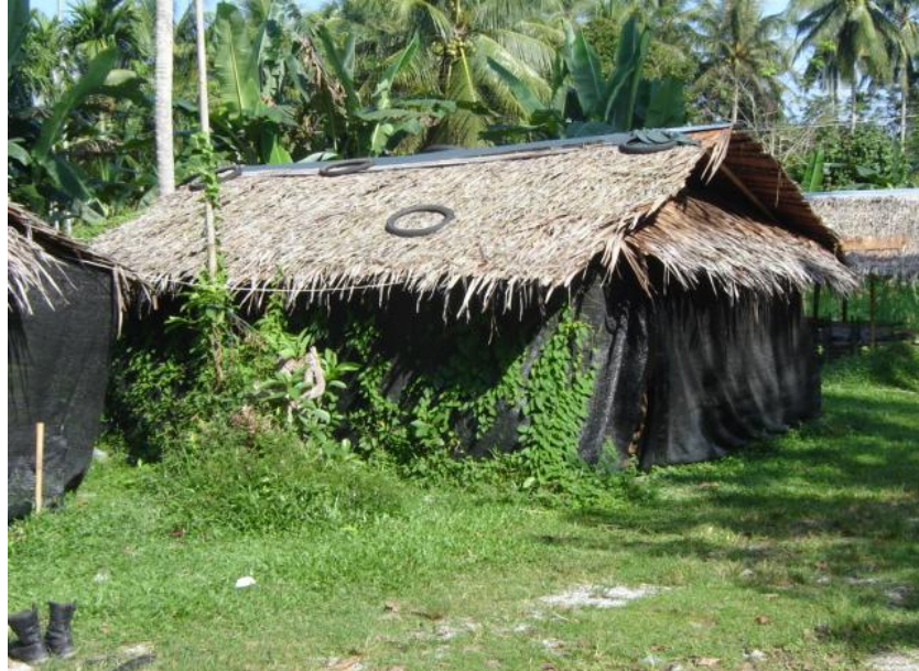
แผนภาพที่ 2-8 ผนังของที่พักอาศัยทำด้วยตาข่ายกรองแสงไม่สามารถกันฝนและอุณหภูมิได้
