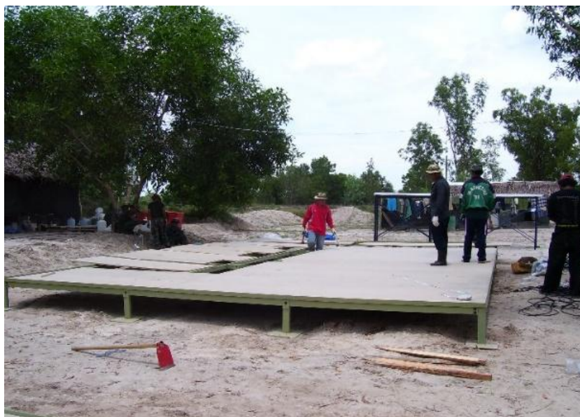
แผนภาพที่ 3-8 การปูแผ่นไม้พื้นสำเร็จรูปบน โครงสร้างคานเหล็ก
