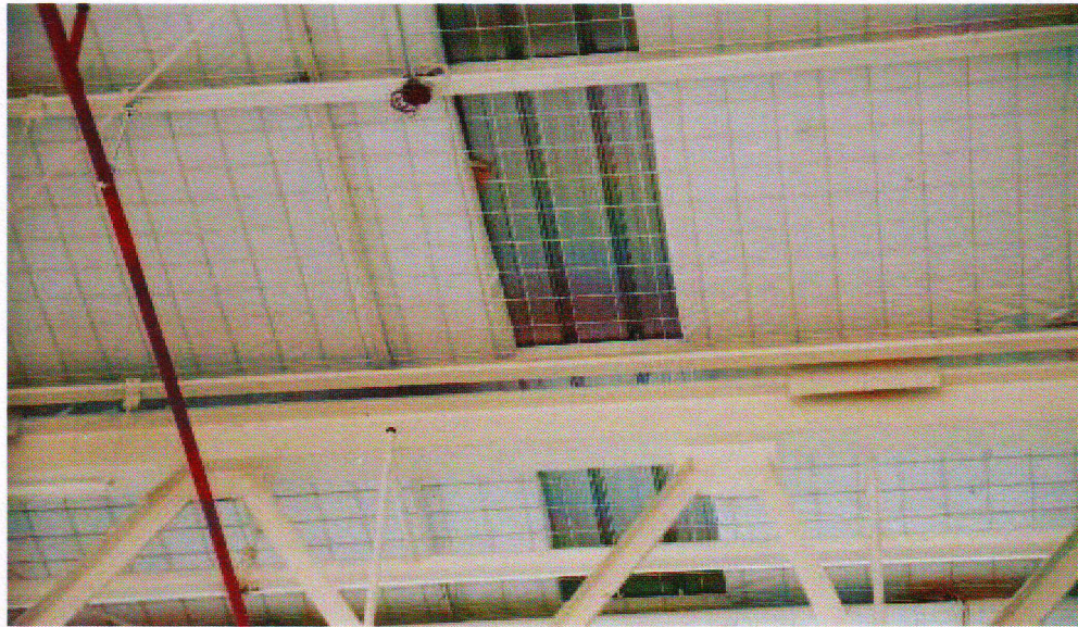
รูปภาพการปูฉนวนตามขวางแป ด้วยการติดตั้งWire mesh บนแป
