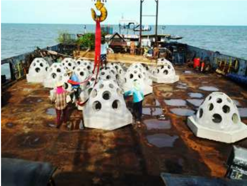
แผนภาพที่ 2 - 21 การวางแนวปะการังเทียมรูปทรงโดมฐานเปิด บริเวณอุทยานสิ่งแวดล้อมนานาชาติสิรินธร จังหวัดเพชรบุรี
