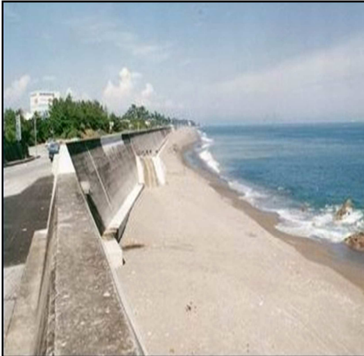
แผนภาพที่ 2 - 13 กำแพงป้องกันคลื่นริมชายหาดแบบลาดเอียงในญี่ปุ่น
