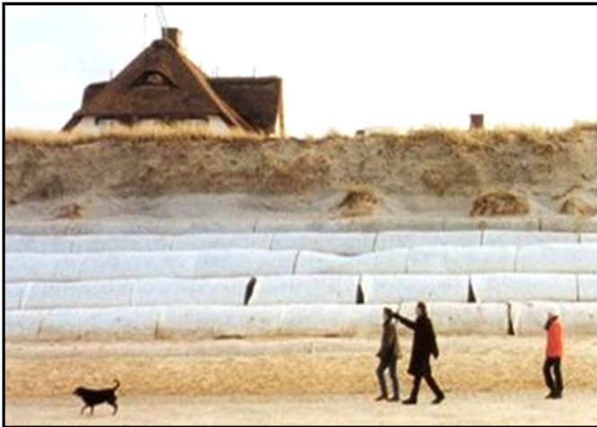
แผนภาพที่ 2 - 10 การใช้ผ้าใยสังเคราะห์ในการฟื้นฟูและป้องกันการกัดเซาะชายหาดในสหพันธ์ สาธารณรัฐเยอรมนี
