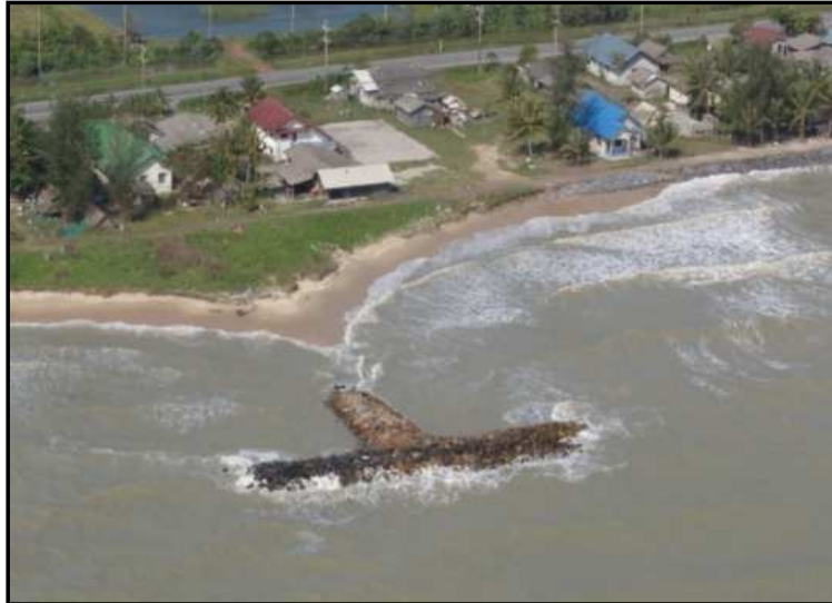
แผนภาพที่ 2-22 รอดักทรายแบบตัวทึบบริเวณอำเภอระโนด จังหวัดสงขลา
