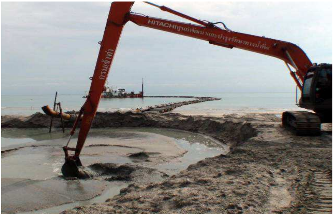
แผนภาพที่ 2 – 5 การเสริมทรายชายหาดชลาทัศน์ อำเภอเมือง จังหวัดสงขลา
