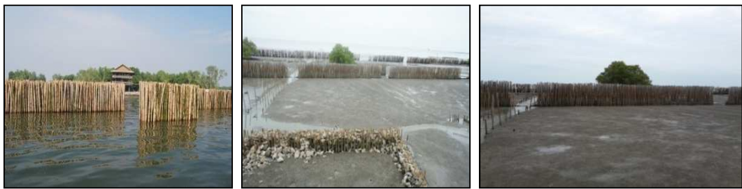
บริเวณหมู่ที่ 8 ต.พันท้ายนรสิงห์ อ.เมือง จ.สมุทรสาคร ระยะทาง 2,350 เมตร แผนภาพที่ 4-1 โครงการปักแนวไม้ไผ่ชะลอความรุนแรงของคลื่นกัดเซาะชายฝั่ง ปี 2553 – 2556 (ต่อ)
