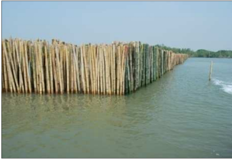
แผนภาพที่ 4-1 โครงการปักแนวไม้ไผ่ชะลอความรุนแรงของคลื่นกัดเซาะชายฝั่ง ปี 2553-2556 (ต่อ)
