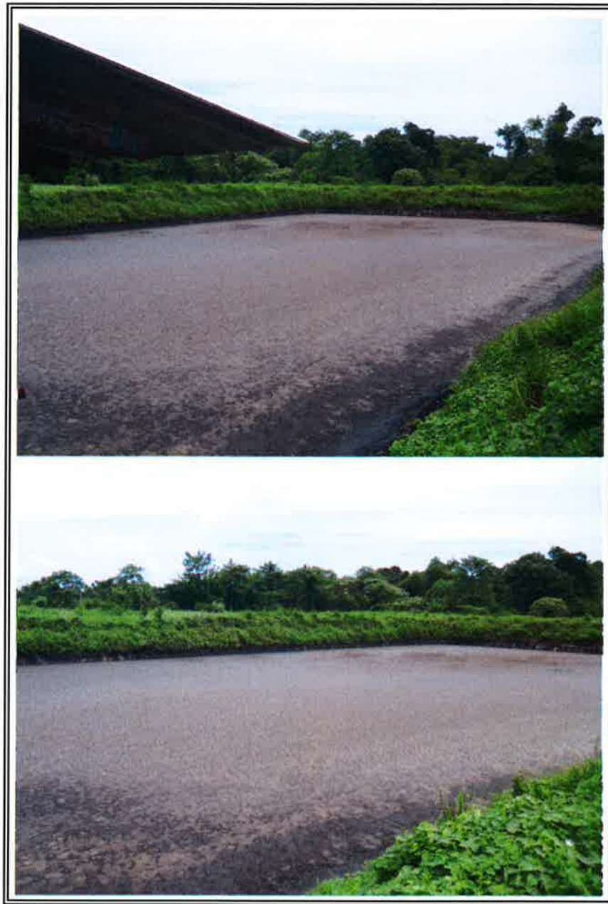
แผนภาพที่ ๓-๑๑ ตัวอย่างบ่อกักเก็บน้ำเสียจากโรงงานปาล์มน้ำมัน
