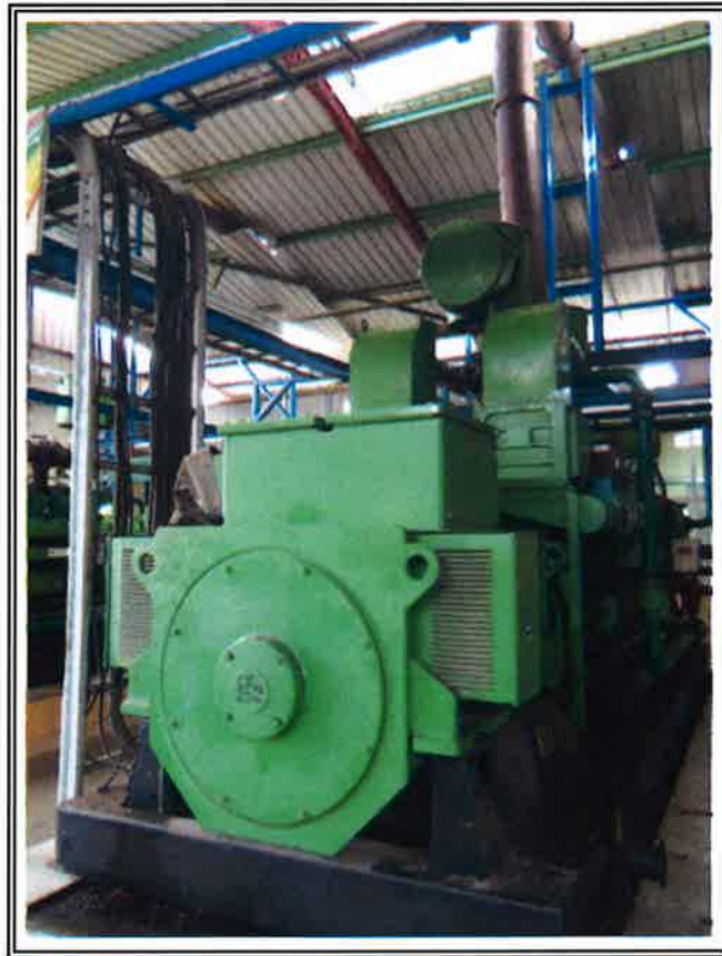
แผนภาพที่ ๓-๑๕ เครื่องยนต์ก๊าซชีวภาพเพื่อผลิตกระแสไฟฟ้า
