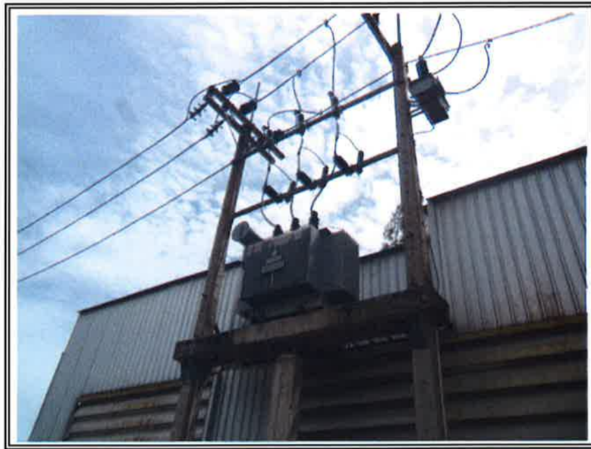
แผนภาพที่ ๓-๑๖ หม้อแปลงไฟฟ้า
