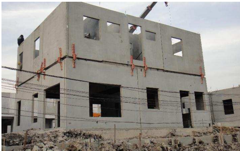
แผนภาพที่ 2-9 ลักษณะของชิ้นส่วนสำเร็จรูปคอนกรีตที่ผลิตเป็นชิ้นส่วนผนัง โครงสร้างรับแรง
