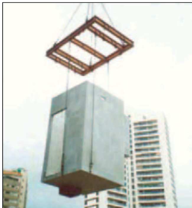
แผนภาพที่ 3-3 การขนส่งห้องน้ำคอนกรีตสำเร็จรูปขึ้นไปยังอาคารเพื่อทำการติดตั้ง
