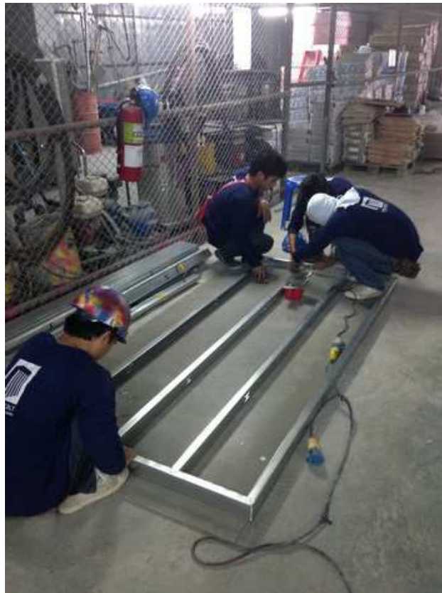
แผนภาพที่ 4-6 การประกอบ โครงผนังห้องน้ำ
