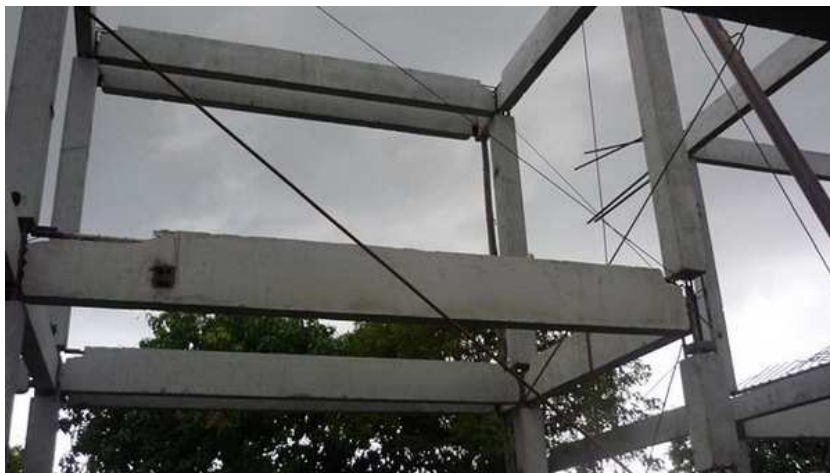
แผนภาพที่ 2-9 ลักษณะของชิ้นส่วนสำเร็จรูปคอนกรีตที่ผลิตเป็นชิ้นส่วนผนัง โครงสร้างรับแรง
