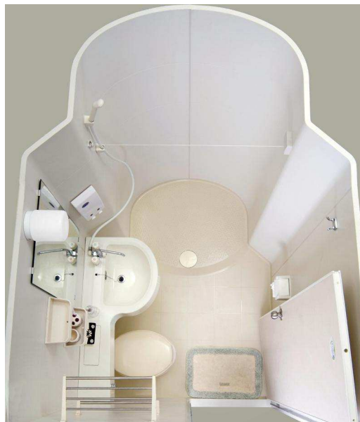
แผนภาพที่ 3-5 รูปแบบของห้องน้ำสำเร็จรูปแบบแยกชิ้นแผงผนังและกระเบื้องพื้นติดตั้งในที่ที่มีการผลิตและใช้งานจริงในต่างประเทศ
