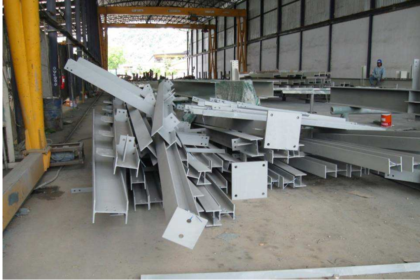
แผนภาพที่ 2-4 การผลิตชิ้นส่วนสำเร็จรูปโครงสร้างอาคารจากเหล็กรูปพรรณในโรงงาน
