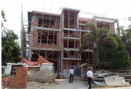
แผนภาพที่ ๓-๕ การก่อสร้างอาคารที่พักอาศัยในกรุงย่างกุ้ง
