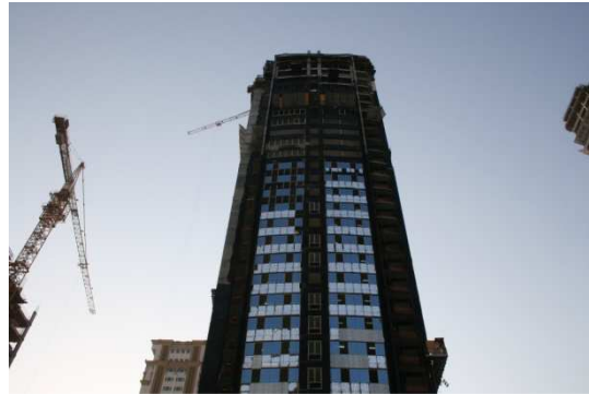
แผนภาพที่ ๓-๒๐ โครงการก่อสร้างอาคารสำนักงานที่ประเทศกาตาร์
