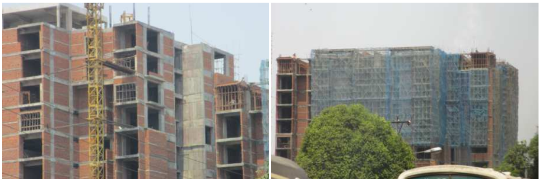
แผนภาพที่ ๓-๗ รูปแบบการก่อสร้างที่ยังเน้นรูปแบบการก่อสร้างแบบหล่อในที่และก่ออิฐ
