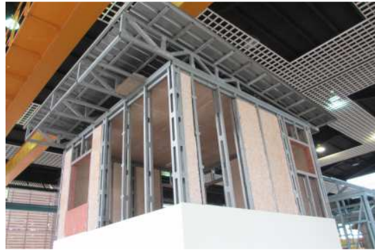
แผนภาพที่ ๓-๑๓ โครงเหล็กสำเร็จรูปที่สาธิตในศูนย์ IBS
