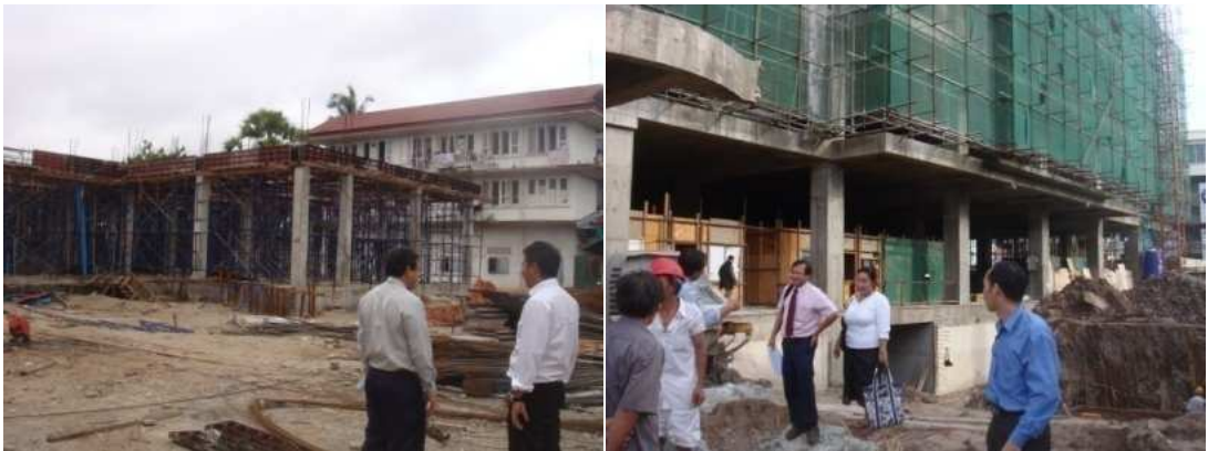
แผนภาพที่ ๓-๑๕ การก่อสร้างอาคารแบบหล่อในที่ในประเทศลาว
