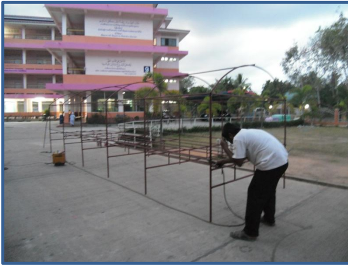
แผนภาพที่ ๕-๑๐ ประกอบโครง โรงเรือนเพื่อปลูกผักไร้ดิน
