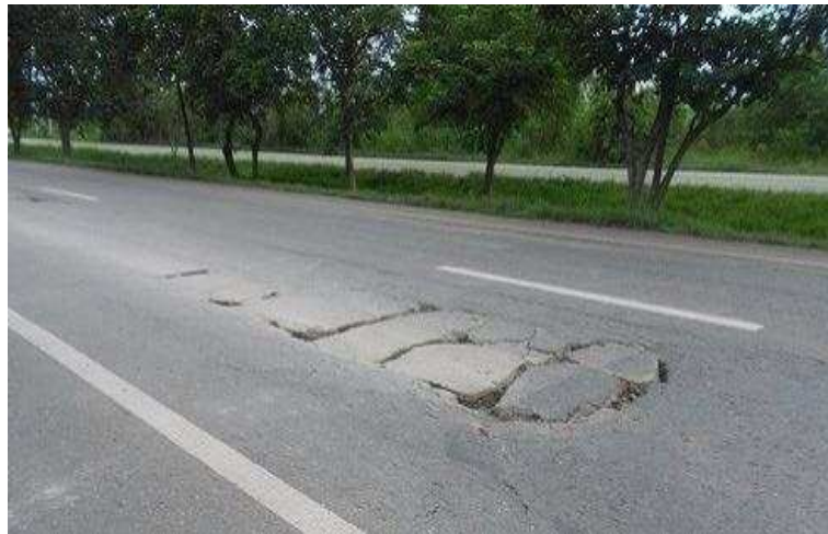
ก) ความเสียหายจากการรับน้ำหนักบรรทุก
