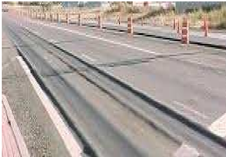
ข) ความเสียหายแบบร่องล้อบนผิวทาง
